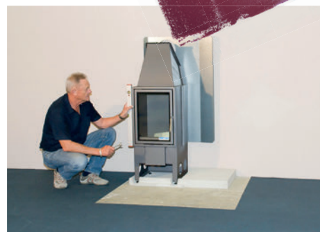
Ustawić wkład kominkowy za pomocą poziomiczy. (3)
