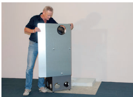
Zamontuj zabezpieczenie przeciwpożarowe na wkładzie kominkowym (akcesorium specjalne). (2)
